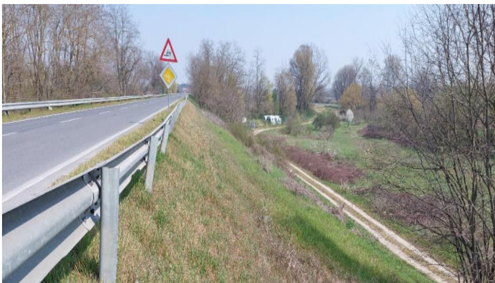
Foto 2: sponda destra. Visuale del rilevato che sarà allargato verso la strada sterrata
