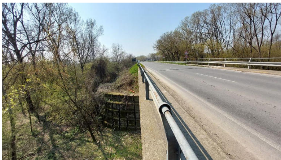
Foto 8: sponda in sinistra. Il nuovo terrapieno sarà realizzato prolungando quello esistente fino alla sommità
