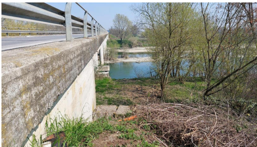
Foto 9: vista dalla sponda sinistra del ponte sul quale sarà ancorata la ciclovia. L'approdo della struttura in destra e sinistra idrografica necessita l'ampliamento dei terrapieni stradali verso sud.
