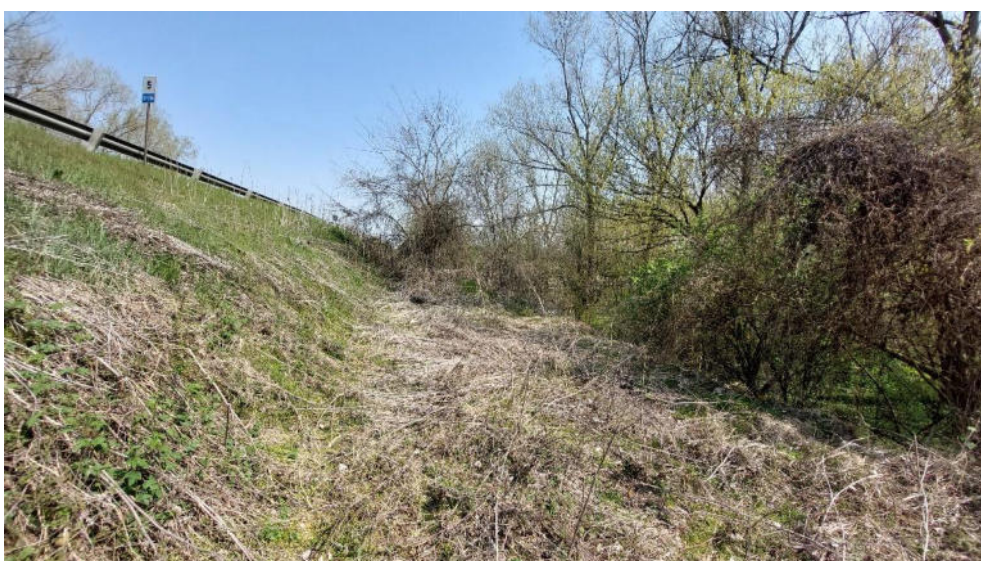
Foto 3: vista del rilevato in sponda sinistra. In questo il nuovo terrapieno sarà posizionato sull'allargamento del rilevato esistente
